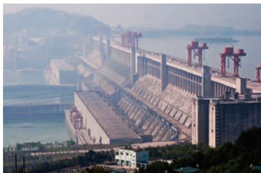
图1-29 混凝土重力坝
